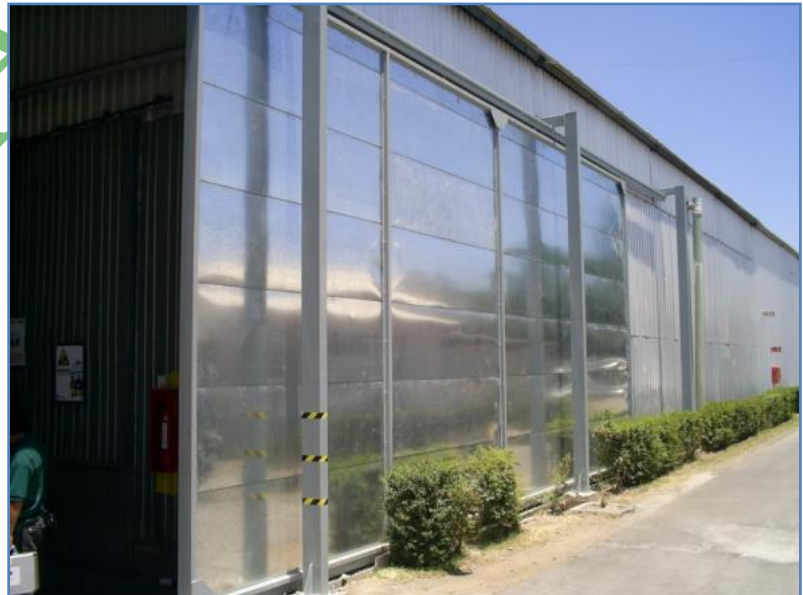
Ilustración 2 Configuración y aislamiento acústico portón PRO ACUS RW35
